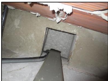
Photo N° 1141 AMIANTE CIMENT - -placards technique rdc à +8 Planchers Plaques planes (Fibres- ciment)
